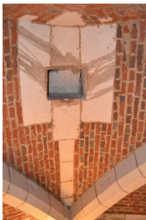
Figure 4: Soupirail aménagé dans la voûte, donnant sur le chœur de la cathédrale et bouché au XVIII e siècle.
