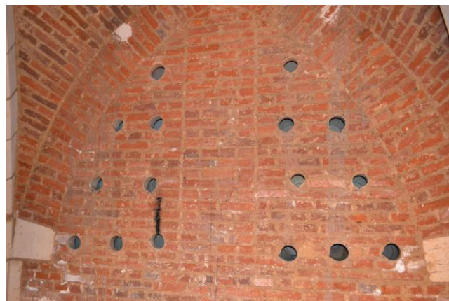
Figure 1: Mur ouest du caveau
