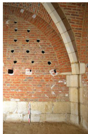
Figure 2: Moitié ouest du mur sud
